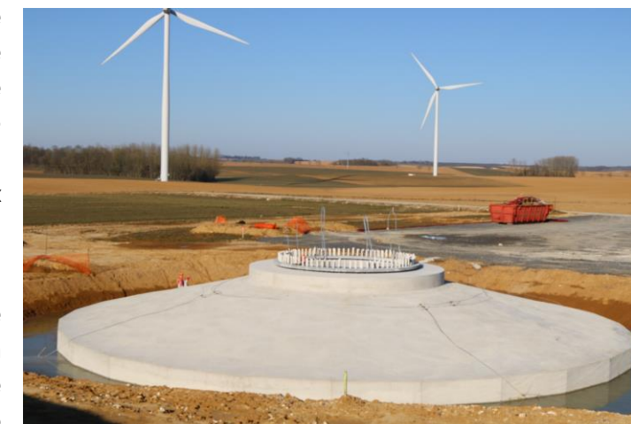
Fondation avant recouvrement
