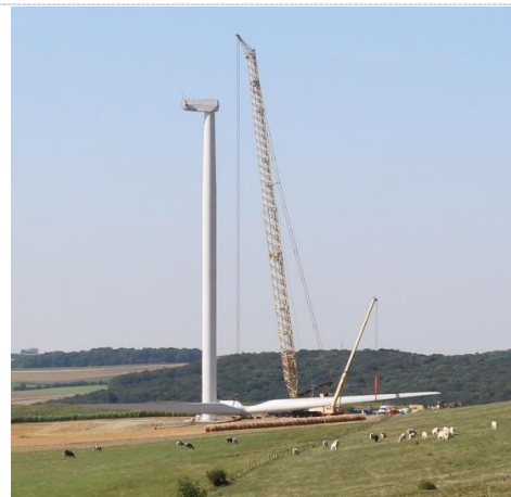
Rotor assemblé au sol avant levage (Source : Ora environnement)
