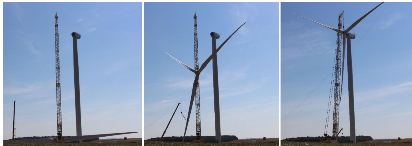
Etapas du montage du rotor d'éolienne (Source : Ora environnement)
