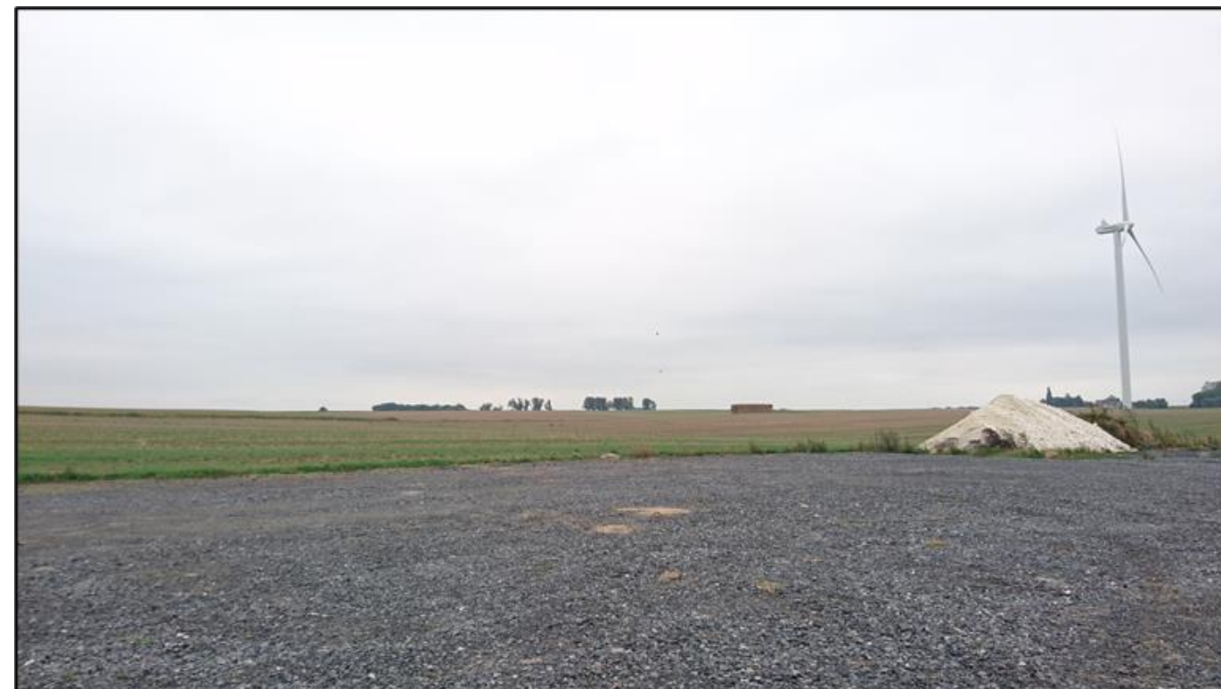
Figure 30 : Illustration d'un sol minéral appliqué à une plateforme de montage (Source : wpd onshore France)
